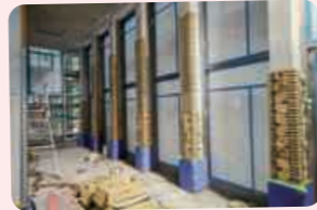
学生が製作した装飾タイルの施工の様子
