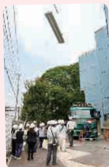
PC床版架設工事見学の様子
